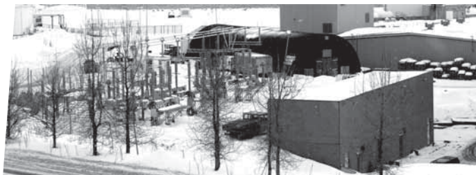
Spennistöð NORAK í byggingu
